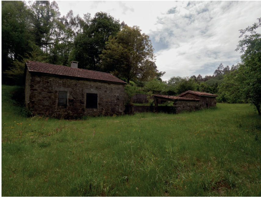
Foto descriptiva de todo o edificio do muíño
